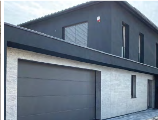
„F“ Fassade Fassadenbeschichtung
